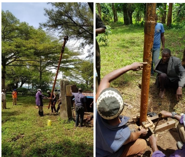
Entfernung des verrosteten Pumprohres aus dem Brunnen
